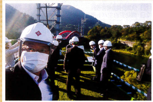
橋梁工事現場の視察
